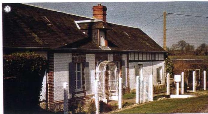
Construction métisse...de briques et de pans de bois. L'enduit blanc cache un mur en silex que l'on retrouve à la base du bâtiment.
