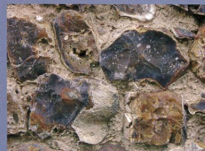
Moellons de silex aux arêtes vives et aux nuances colorées brillantes liés par un mortier.
