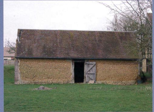
La bauge est un mélange de terre argileuse et limoneuse, d'eau et de fibres. La densité de fibres dans le mélange qui rend la maçonnerie de terre cohérente, permet ainsi l'édification d'un mur en le montant par levées successives sans que l'usage d'un coffre soit nécessaire.
