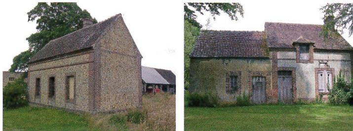
Dans le cas des maçonneries en silex, l'irrégularité du matériau en lui-même et de ses assises ne permet pas une étanchéité et une protection thermique optimales. Il est alors indispensable d'enduire la façade dans sa totalité en prenant toutefois garde de laisser les éléments en briques apparents. Dans le cas des bâtiments à fonction agricole, un joint large au nu des briques des chaînes d'angle et des encadrements de baies, qui affleure les pierres, est suffisant.
