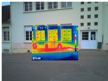
Diagnostic d'un bâtiment à la caméra thermique
